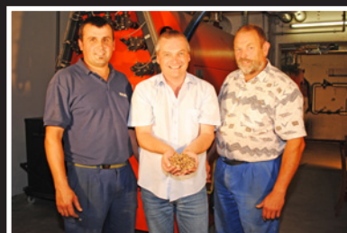
Die Erweiterung der Nahwärmeversorgungsanlage fand zwischen 2008 und 2010 statt. Die bestehende Anlage wurde außerdem optimiert.
