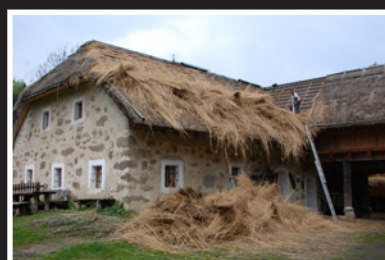
Das Dach des Freilichtmuseums Großdöllnerhof wurde mit einem Schilfdach neu eingedeckt. Es sollte jetzt für längere Zeit halten.
