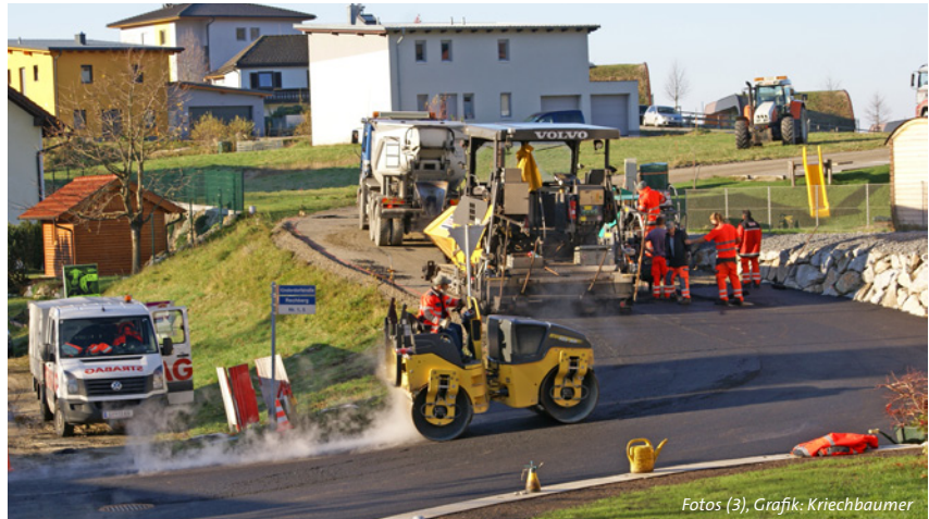
Die Gemeindestraße Lebensplatz wurde mit einer Steinschichtung abgegrenzt und asphaltiert.
