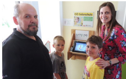
Die Fotovoltaikanlage wurde von Elektro Naderer installiert und ist kommendes Jahr Bestandteil im Unterricht.
