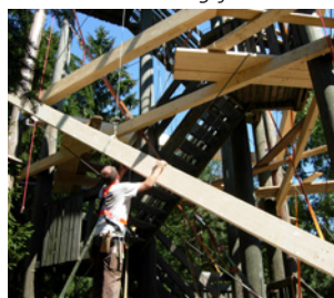
Auch die waagrechten Balken wurden erneuert und mit Blech überzogen
