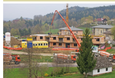
Viel Beton wurde für die zweite Decke benötigt
