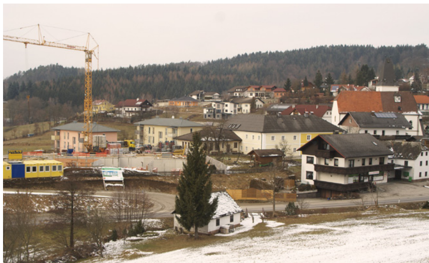
Ein Blick auf die Baustelle „Lebensplatz Rechberg“, wo derzeit zwölf Wohnungen errichtet werden.
