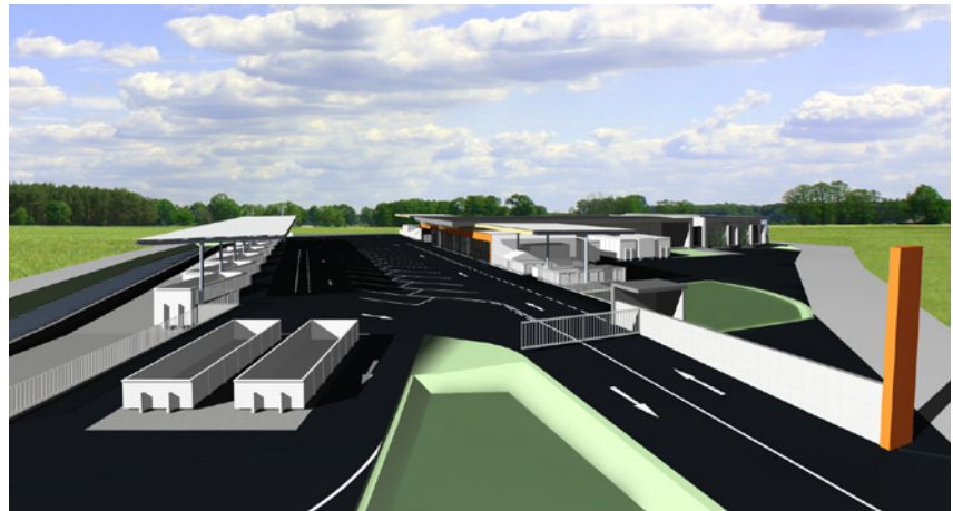
Das neue, moderne Altstoffsammelzentrum in Perg besticht durch seine einfache Erreichbarkeit.
