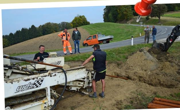
Die Trinkwasserleitung in die Ortschaft Hiesbach wird nicht nur gegraben, sondern – wo es geht – mit Spezialmaschinen mittels Spülbohrung eingezogen.
